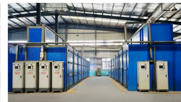
Curing step 固化工序
